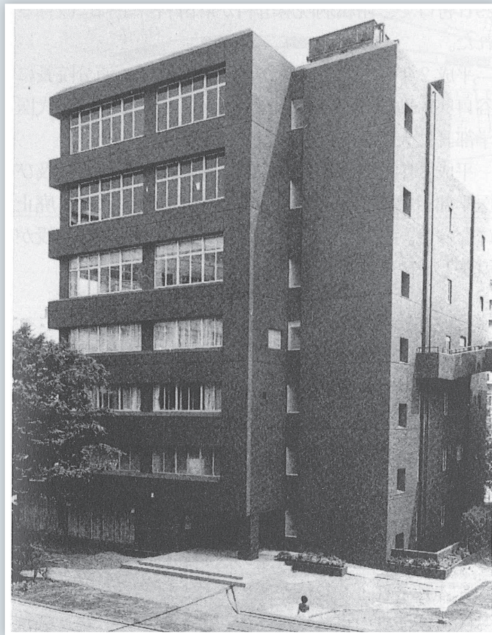
5号館（厚生棟）の落成
