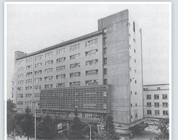
1号館(管理棟)の竣工
