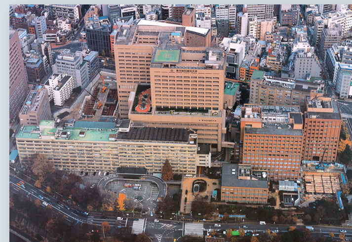
新3号館の地中基礎工事が始まる。大学院重点化により、医歯学総合研究科、保健衛生学研究科を整備。東京工業大学、一橋大学、東京外国語大学と本学による四大学連合憲章を締結し「複合領域コース」がスタート。
