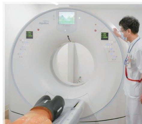
同センター内に独立して設置されたCT室
